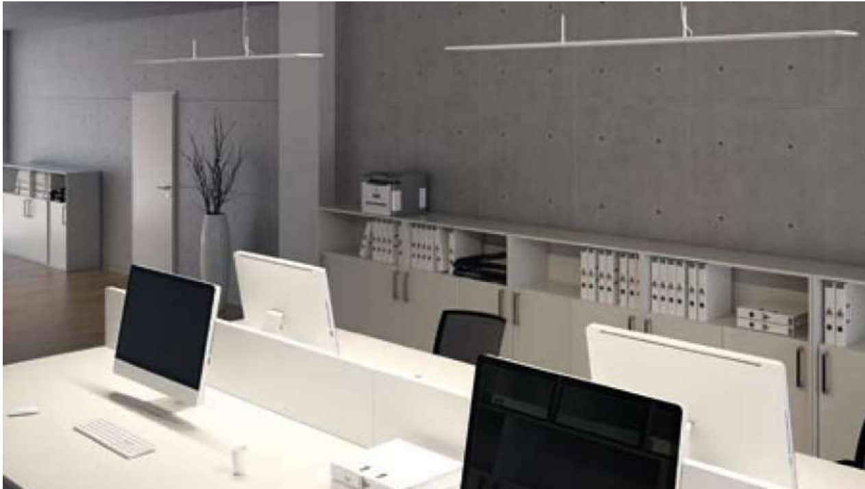
Rys. 1. Stanowiska pracy z monitorami ekranowymi – widoczne zawieszane wysoko oprawy oświetleniowe [OSRAM]
